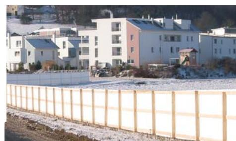
**Struttura di base:** Per accrescere la resistenza alle intemperie (es. raffiche di vento, forti precipitazioni), si usano tutti pali di 2,4 m di altezza con un'ampiezza di 120 x 160 mm. Fissare su questi tre assi dello spessore di 30 mm. L'asse inferiore deve essere posta a 300 mm dalla base, quella superiore supporta la parte terminale del pannello ISO-PROTECT®. La messa in sicurezza della base è di competenza dell'impresa edile.
